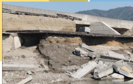
基礎地盤の洗掘
