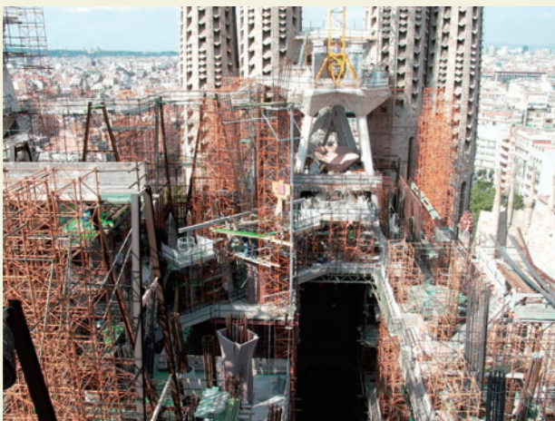
図2 サグラダ・ファミリア教会の工事現場 (撮影: 福井大学 桑水流 理准教授)
