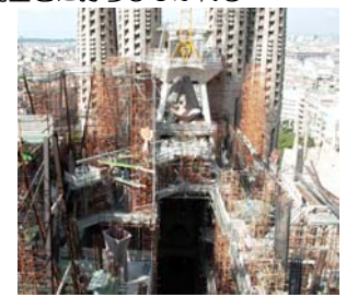
建築中のサグラダファミリア。実は鉄筋コンクリート造（撮影：福井大学 薬水流理 准教授）
